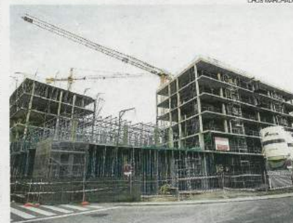
► Pisos en construcción en la avenida Cataluña, frente a la Casa Solans.
